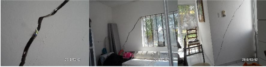
**Figura 1.** Estructuras considerablemente dañadas por el fenómeno expansión – contracción.
