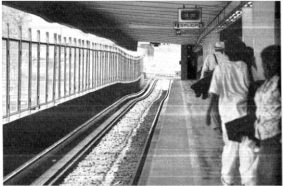
Figura 30. Vista interior de las vías.
