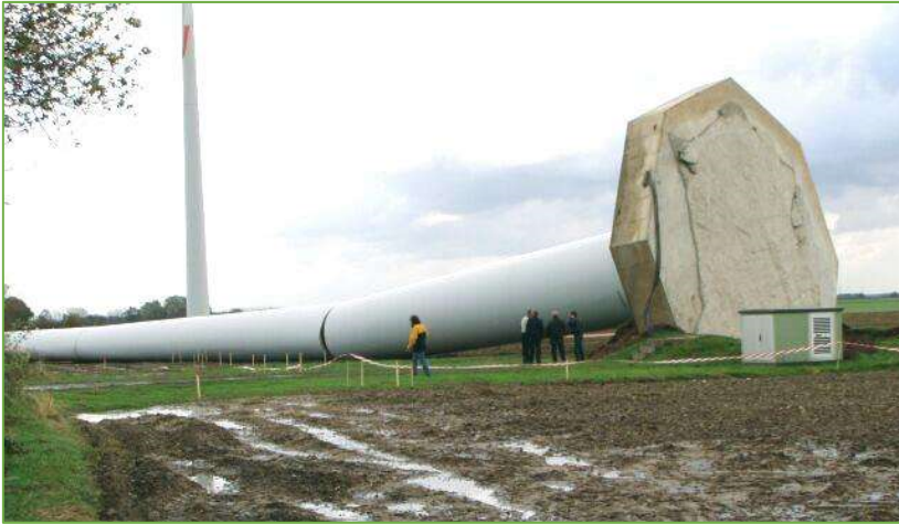
Figura 7. Vuelco de una torre de aerogeneradores.
