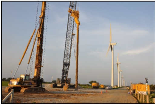
Figura 6. Vista hacia los trabajos en la zona de la cimentación de los aerogeneradores.
