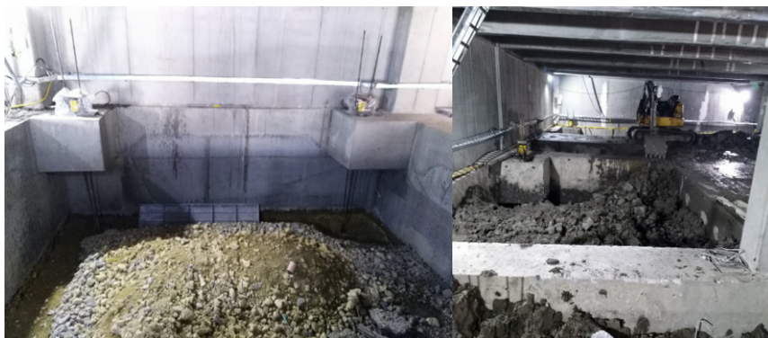
Figura 6. Gatos hidráulicos y excavación de suelo dentro de las celdas.
